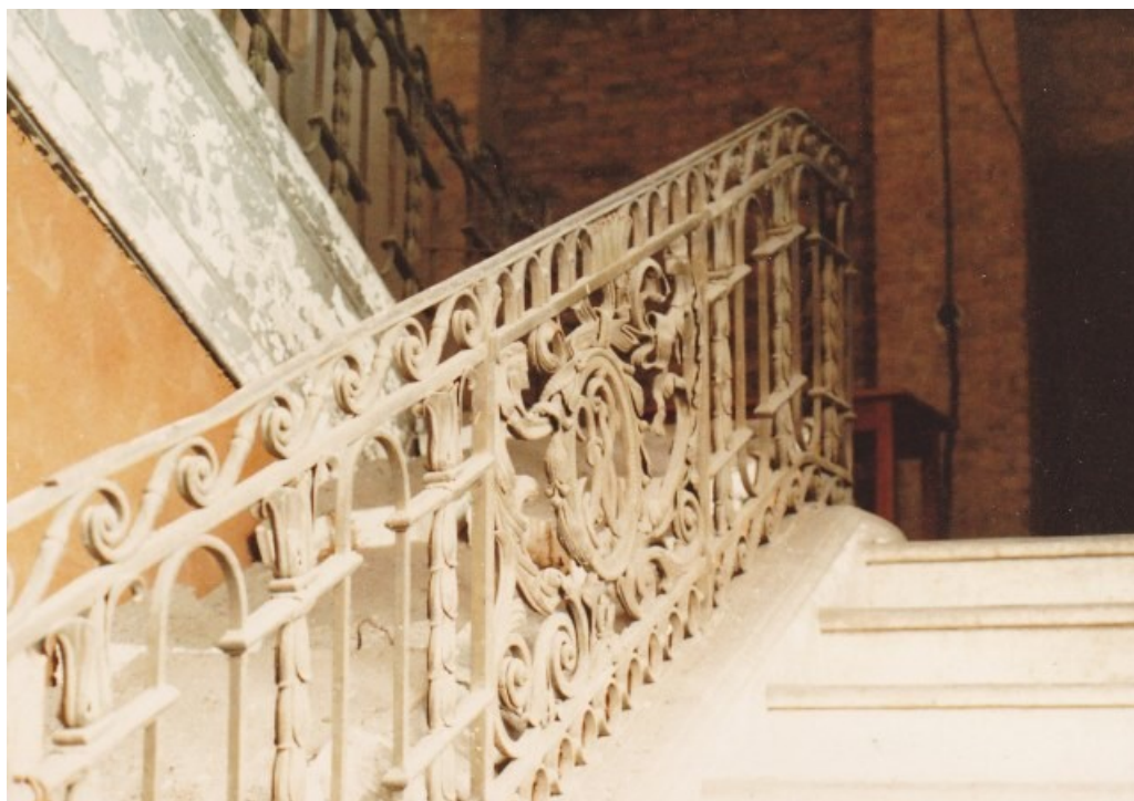
Aufstieg und Abstieg: Treppenhaus im „Esplanade“.
